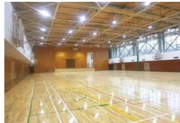
中学・高校体育館内部水平・垂直鉄骨ブレース増設 高効率型照明器具更新
