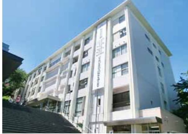
1号館外壁鉄筋コンクリート耐震壁増設
