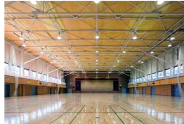
大学体育館内部水平・垂直鉄骨ブレース増設
