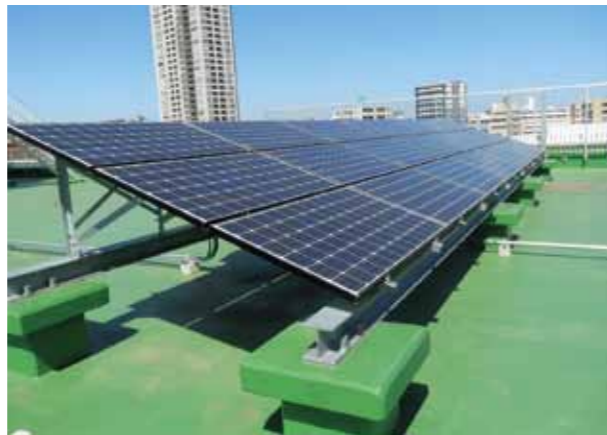
太陽光発電設備新設
