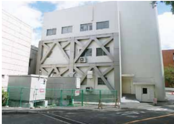
2号館外壁耐震鉄骨ブレース・非常用発電機
