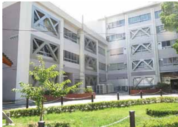
3号館外壁垂直鉄骨ブレース増設
